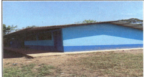
Foto 2: se observa en la fotografia la finalizacion de instalacion de costanera y la aplicacion de pintura en el interior e exterior
