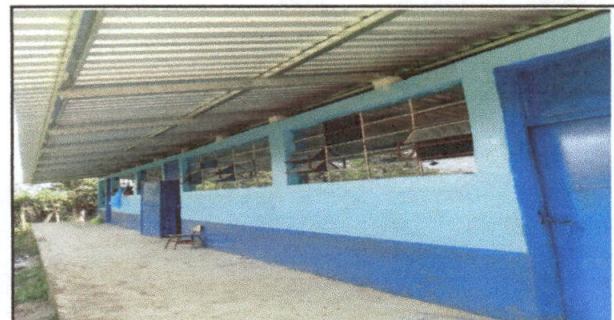
Foto 6: se observa la finalizacion de la instalacion laminas en el corredor
