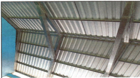
Foto 3: Se evidencia en la imagen la finalizacion de instalacion de laminas troqueladas
